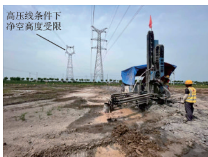
图1 现场试桩试验 Fig.1 Field piling test
