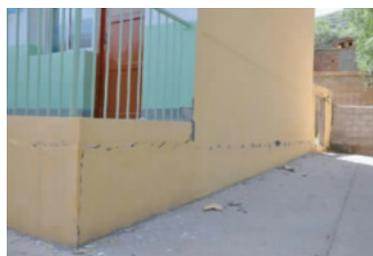
图 2 茶固小学砖混房屋墙体贯通裂缝<sup>[15]</sup>
