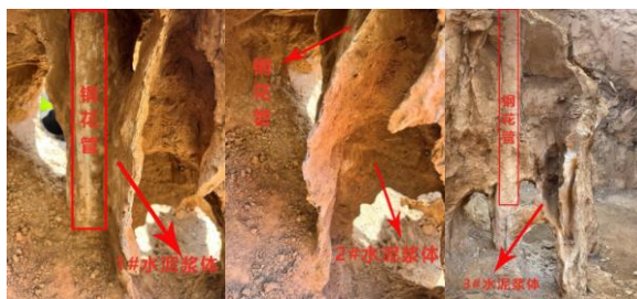
图 20 1~3#水泥浆体挖探调查照片
